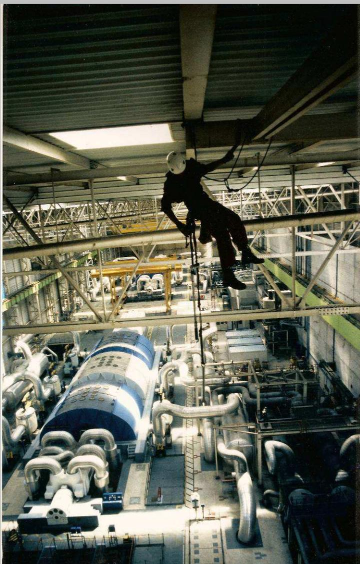
Centrale nucléaire - Inspection et remplacement d'une poutre de la structure métallique du plafond de la salle des machines. (Technicien : *Frédéric Verne*)
