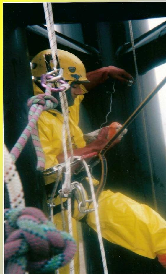
Pylône - Contrôle et mesure d'épaisseur par ultrasons. (Technicien : *Stéphane Janin*)
